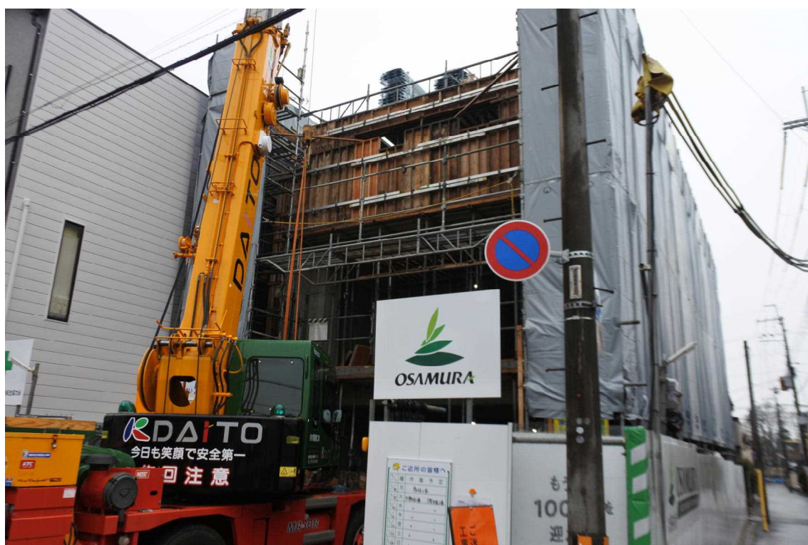
着々と進む工事現場 R3.1.22 撮影
