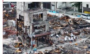
地震と火災で壊滅的な被害が出た「輪島の朝市」1/19 写真
